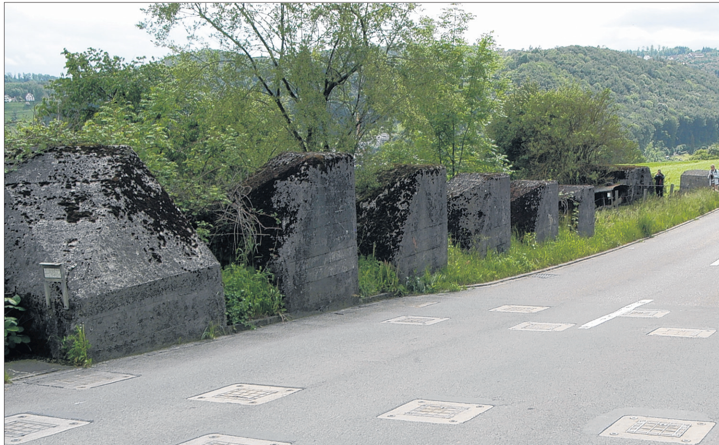
HERTENSTEIN Mit Panzersperren quer durchs Land sollte im Kalten Krieg ein sowjetischer Durchmarsch erschwert werden. WALTER SCHWAGER
